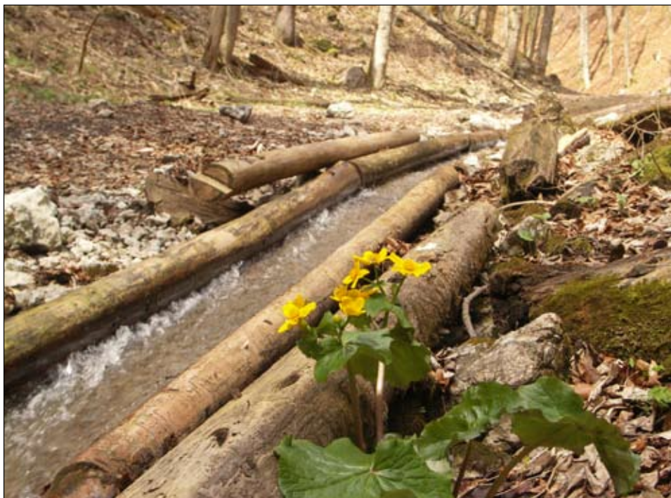
Vodné žlaby na splavovanie rovného dreva boli takmer v každej doline mestských lesov
