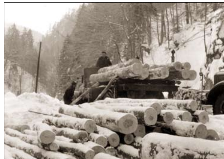
Mechanické nakladanie výrezov pomocou navijáka namontovaného na nákladnom aute
