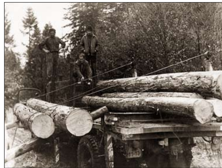
Vytahovanie výrezov navijákom značne uľahčilo prácu pri nakladaní dreva na auto
