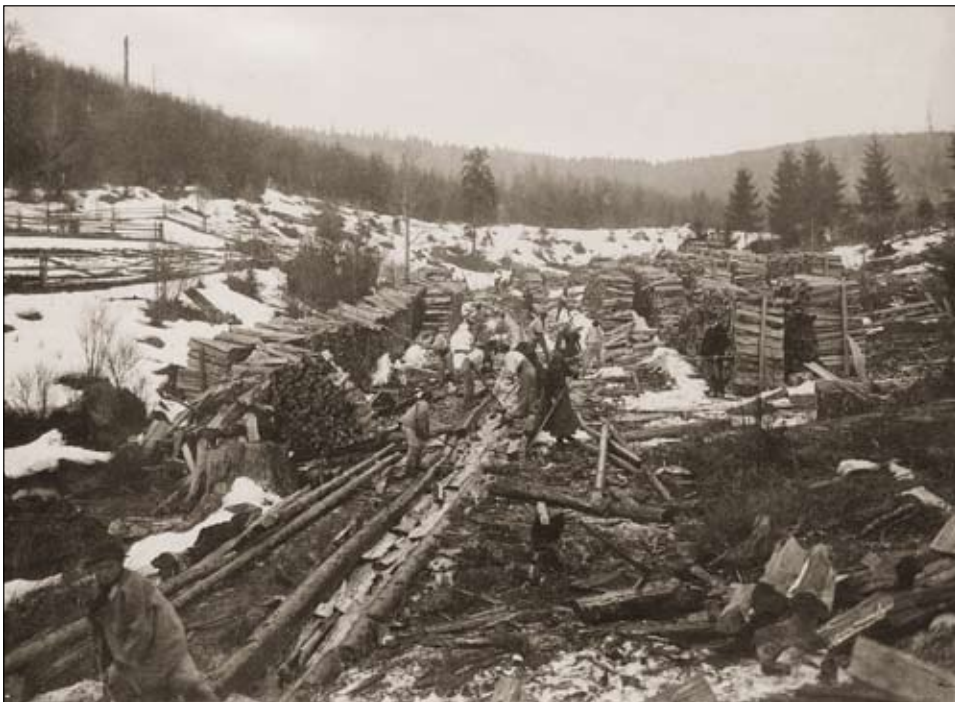
Vhadzovanie rovnaneého dreva do vodného žľabu – flúdra
