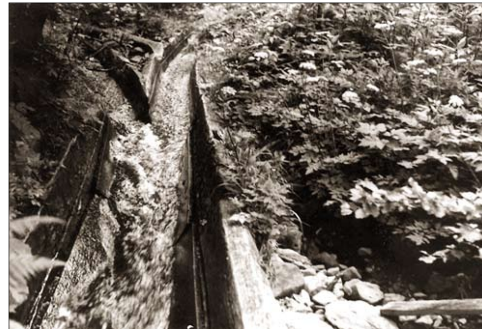
Prepojenie vodných žľabov umožňovalo zvýšiť množstvo vody v žľabe
