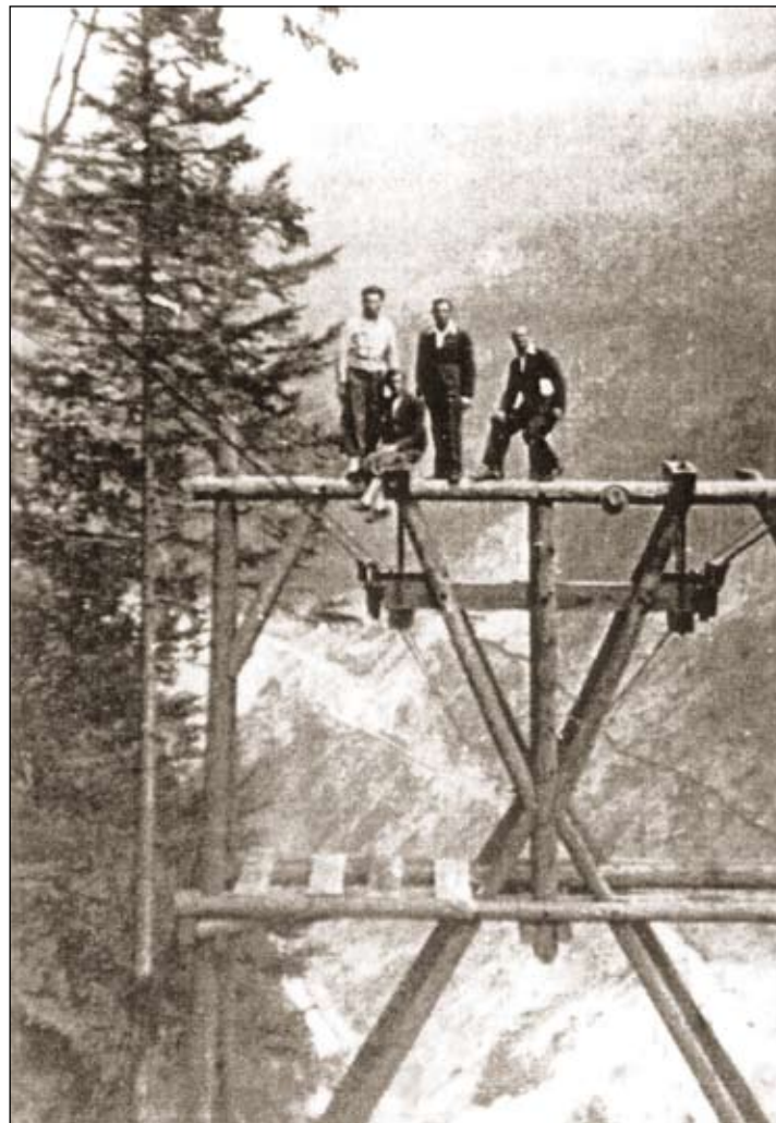
Stavba lanovej dráhy na dopravu kameniva pre železnicu v Hornom Harmanci (1938)
