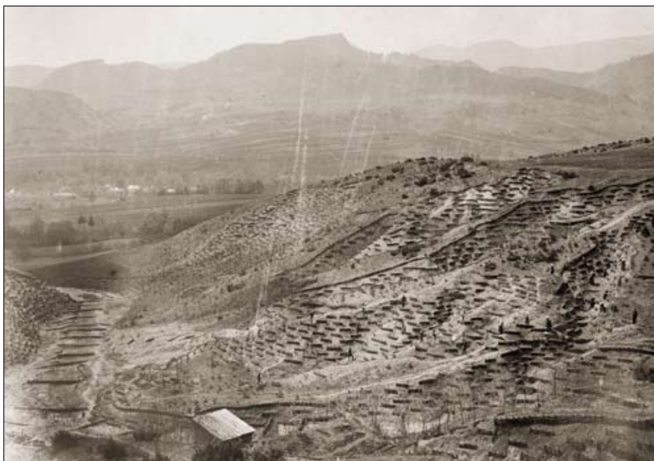
Dokončenie viazania podlavických výmoľov 6. mája 1904
