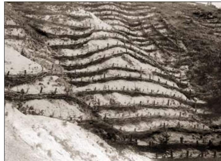
Náročný systém viazania výmoľov prútenými plôtkami
